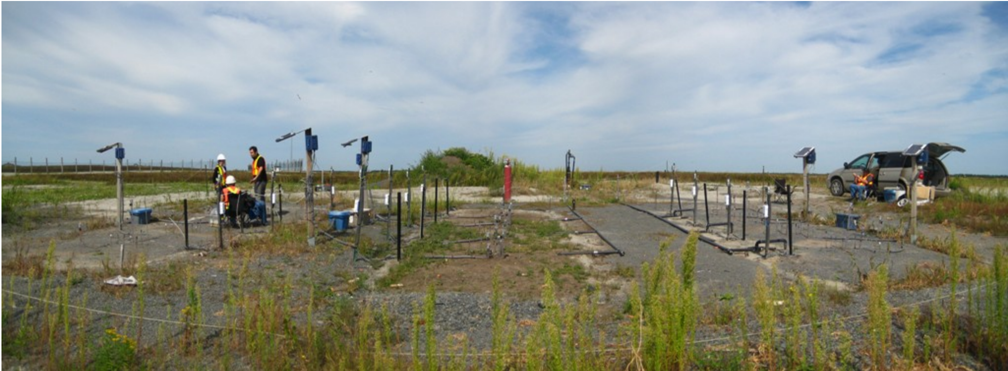
Barrière capillaire et biosystème d'oxydation passive du méthane Site d'enfouissement de St-Nicéphore 2007-2014
