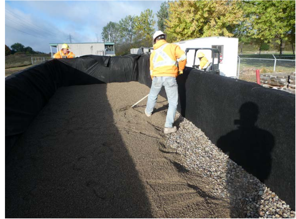
Barrière capillaire et biosystème d'oxydation passive du méthane Actuel McLennan Park (ancien site d'enfouissement) Kitchener, ON 2020
