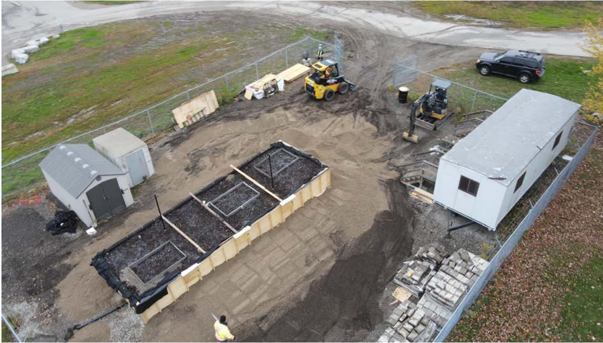
Barrière capillaire et biosystème d'oxydation passive du méthane Actuel McLennan Park (ancien site d'enfouissement) Kitchener, ON 2020
